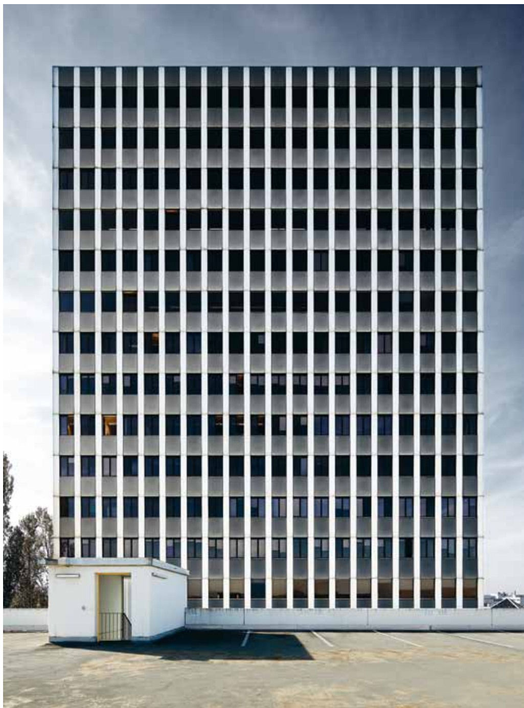
Kozijnvervangig Glögger Flatgebouw Augsburg, Duitsland 2018
