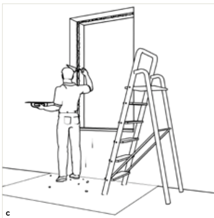
Die Laibung wird von außen und innen wiederhergestellt (verputzen und malern). Bei Bedarf wird ein Gerüst eingesetzt.
